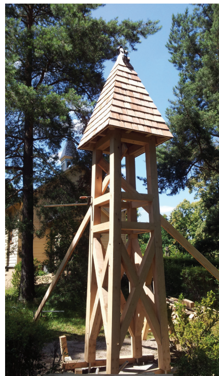
Friedhof Staaken, Glockenturm im Bau, Juli 2013 Foto: Nikolaj Hlebaroff
