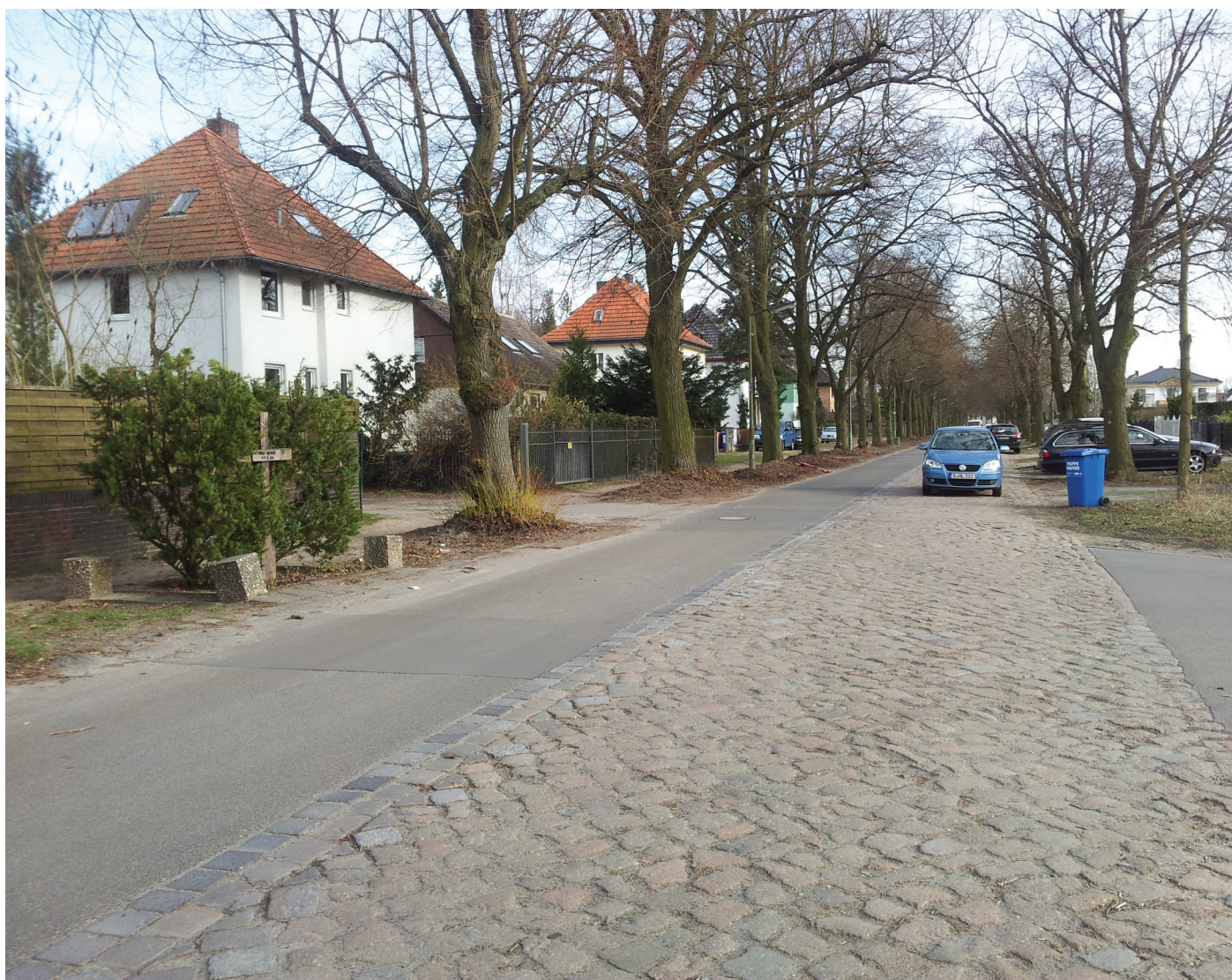
Staaken, Finkenkruger Weg mit Gedenkkreuz für Willi Block, April 2013, Foto: Nikolaj Hlebaroff Die ehemalige Grenzlinie ist noch an der unterschiedlichen Straßenbefestigung zu erkennen.
